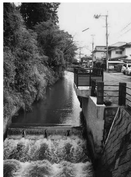
起伏式ゲート（塘町の人工堰）
