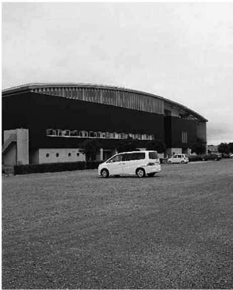
総合体育館北側駐車場舗装予定地
