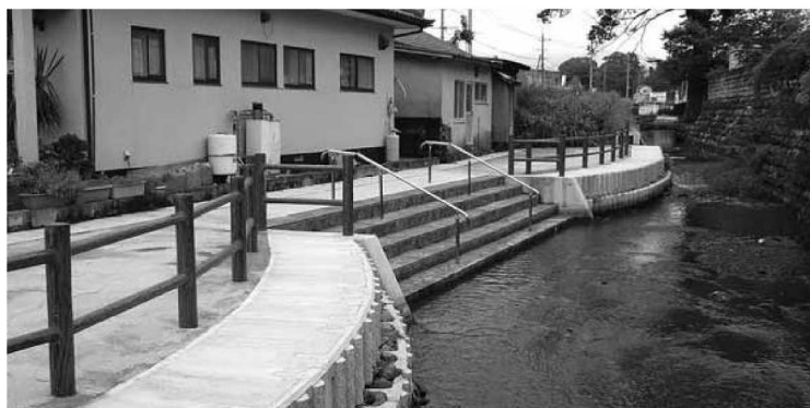
整備した町地区の水路
