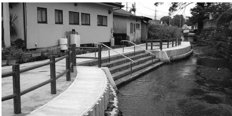
整備した町地区の水路
