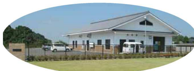
錦野農業集落排水浄化センター
