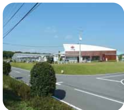
建設された南部工業団地の工場
