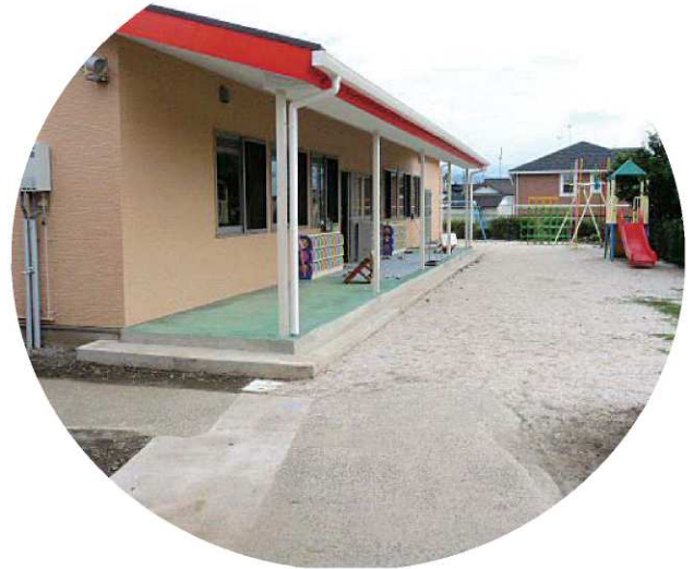
大津保育園 増設園舎
