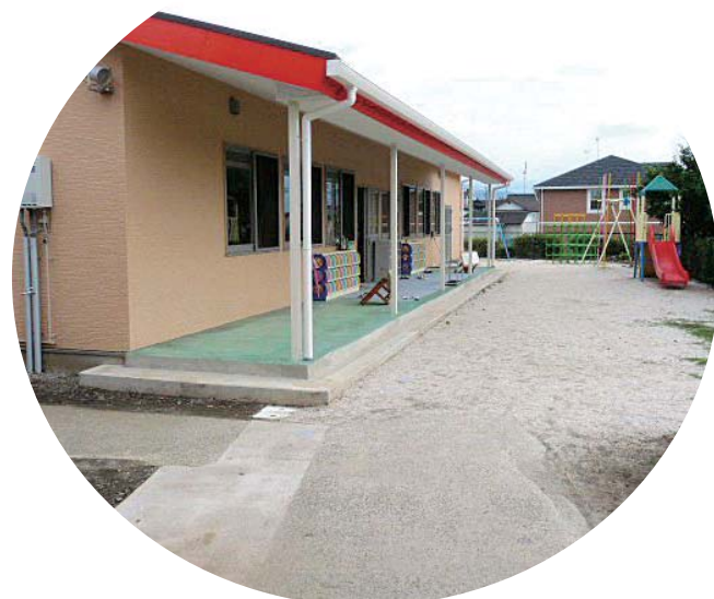
大津保育園 増設園舎
