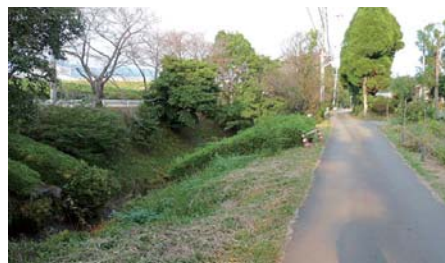
清正公道公園横の里道
