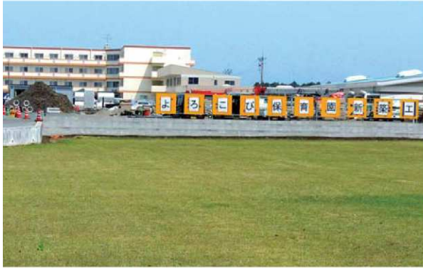
建設中の新設保育所（室）
