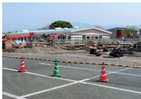
建設中の新設保育所(室)
