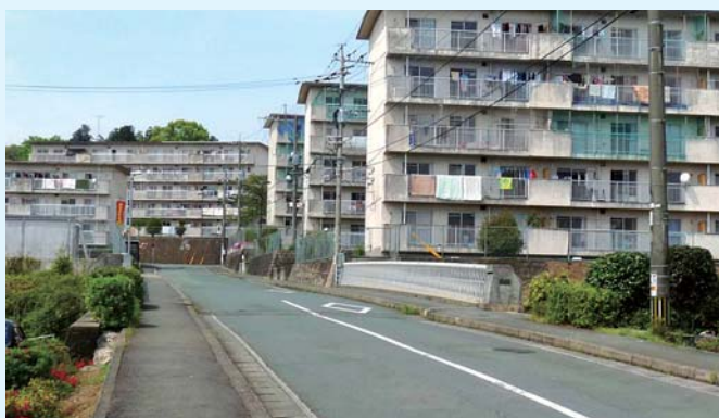
立石団地、あけぼの団地駐車場、西嶽団地側溝工事等
