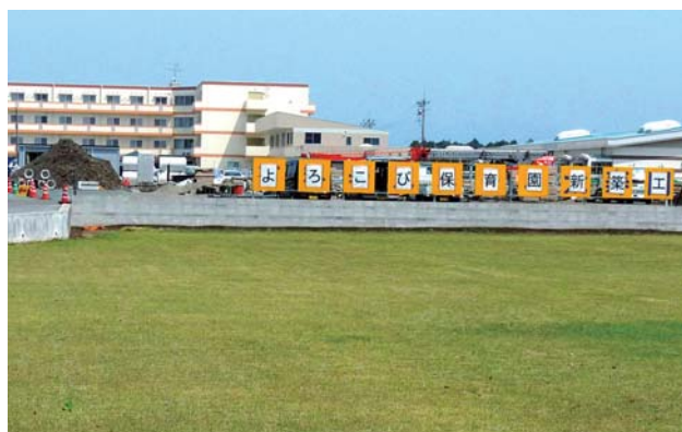
建設中の新設保育所（室）
