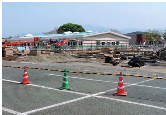
建設中の新設保育所（室）
