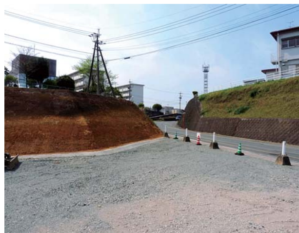
工事が進む駅前楽善線（雇用促進住宅付近）
