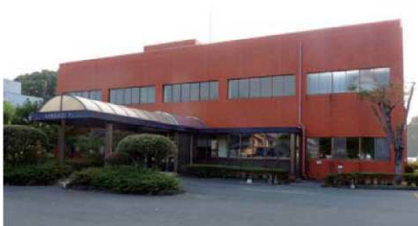
浄化センター
