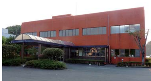
浄化センター
