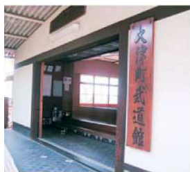
大津町武道館
