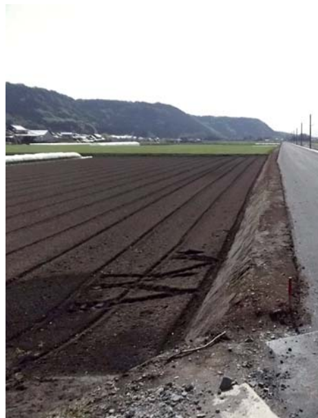
迫井手地区基盤整備
