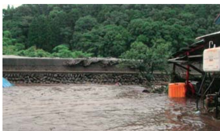
堤防直近の小屋の状況
