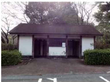
昭和園・杉水公園のトイレ 男・女入り口は別になっているが中に入ると同じ空間中に目隠しが必要
