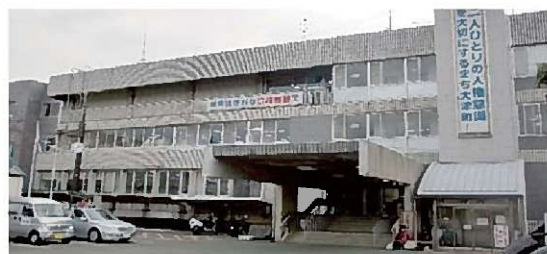
震度5弱で倒壊の危険のある庁舎
