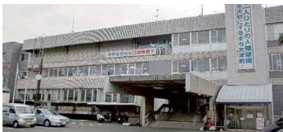
震度5弱で倒壊の危険のある庁舎
