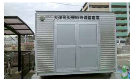
災害時等備蓄倉庫（らくぜんふれあいプラザ）
