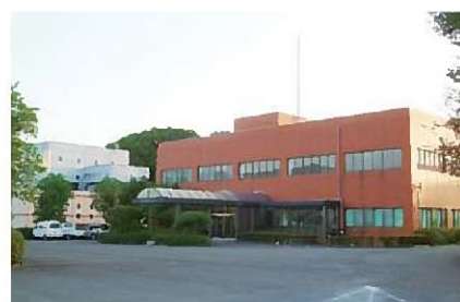
浄化センター
