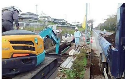
下水道管の布設工事
