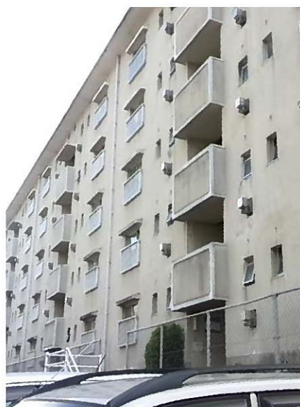
階段室裏にエレベーターをつける場合、住みながら工事ができる
