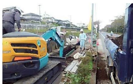
下水道管の布設工事
