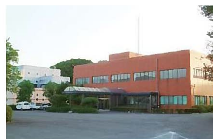
浄化センター
