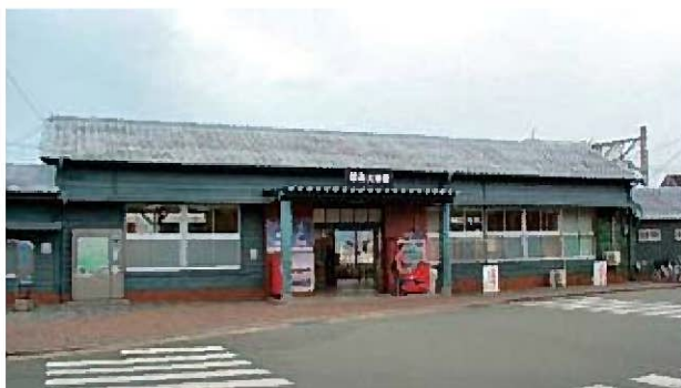
整備工事中の大津駅北口（2016年3月完了予定）
