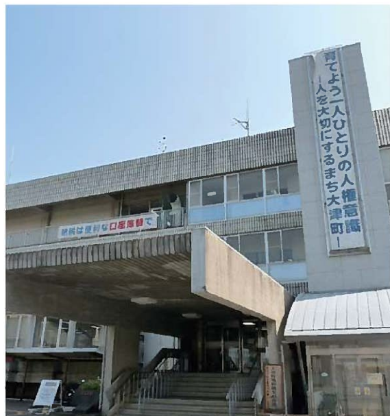
昭和44年建設の大津町庁舎
