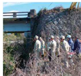
もり橋の現地調査
