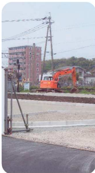
工事中の南口駅舎整備
