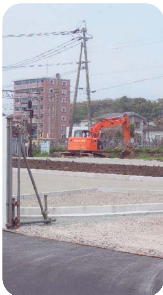
工事中の南口駅舎整備
