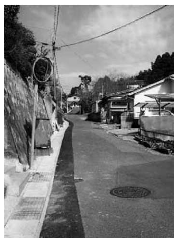
側溝と外灯の整備（水源町）
