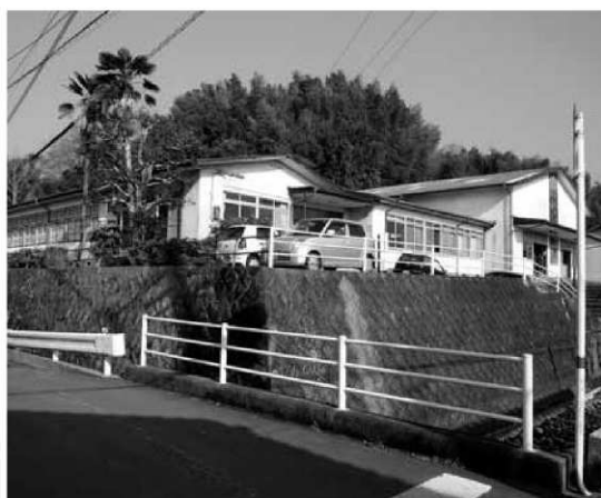
大津地区公民館分館
