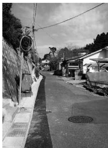
側溝と外灯の整備（水源町）
