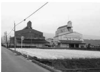
カントリーエレベーター
