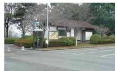
昭和園 トイレ（5ヶ所改修予定）
