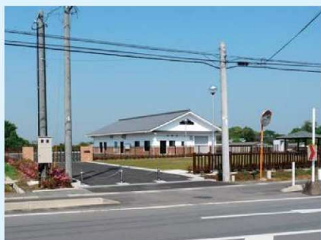
供用開始となった錦野浄化センター
