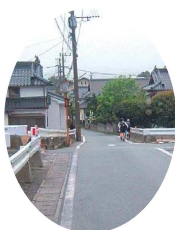
県道工事中の大津小通学路
