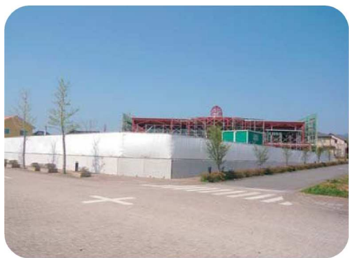
建設中の緑ヶ丘保育園
