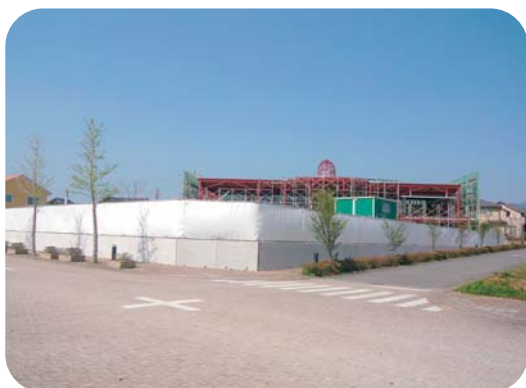
建設中の緑ヶ丘保育園
