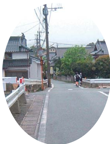
県道工事中の大津小通学路
