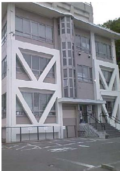
人口57,000人の塩竈市役所 外部から耐震補強がされている
