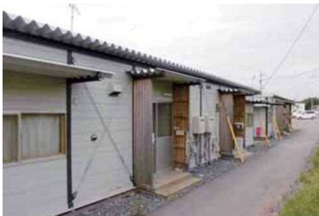
大津町の仮設住宅
