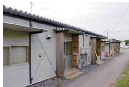
大津町の仮設住宅
