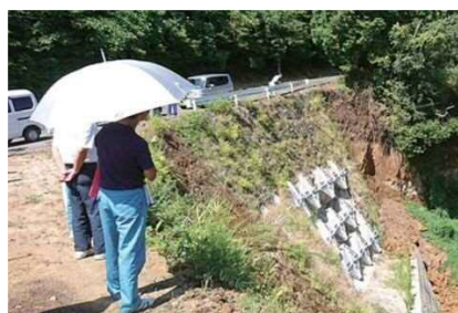
町道古城線道路災害復旧工事
