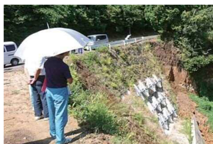
町道古城線道路災害復旧工事
