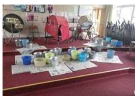
学校の雨漏り時の状況
