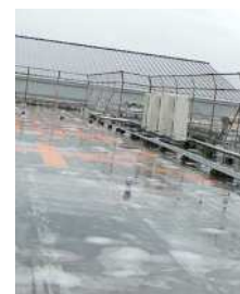
学校施設の屋上
