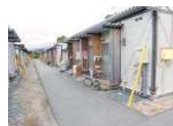
老朽化してきている 仮設住宅
