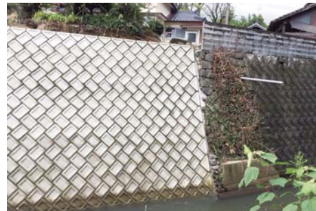
地震による改修
