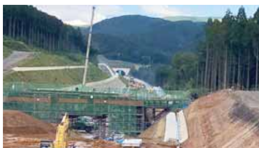
国道57号北側ルート工事状況
