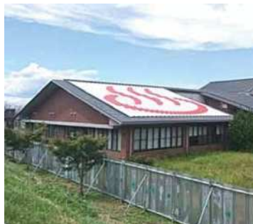
解体予定の「大津温泉 岩戸の里」
