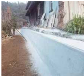
復興基金事業で復旧した擁壁
