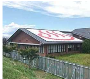
解体予定の「大津温泉 岩戸の里」
