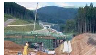
国道57号北側ルート工事状況
