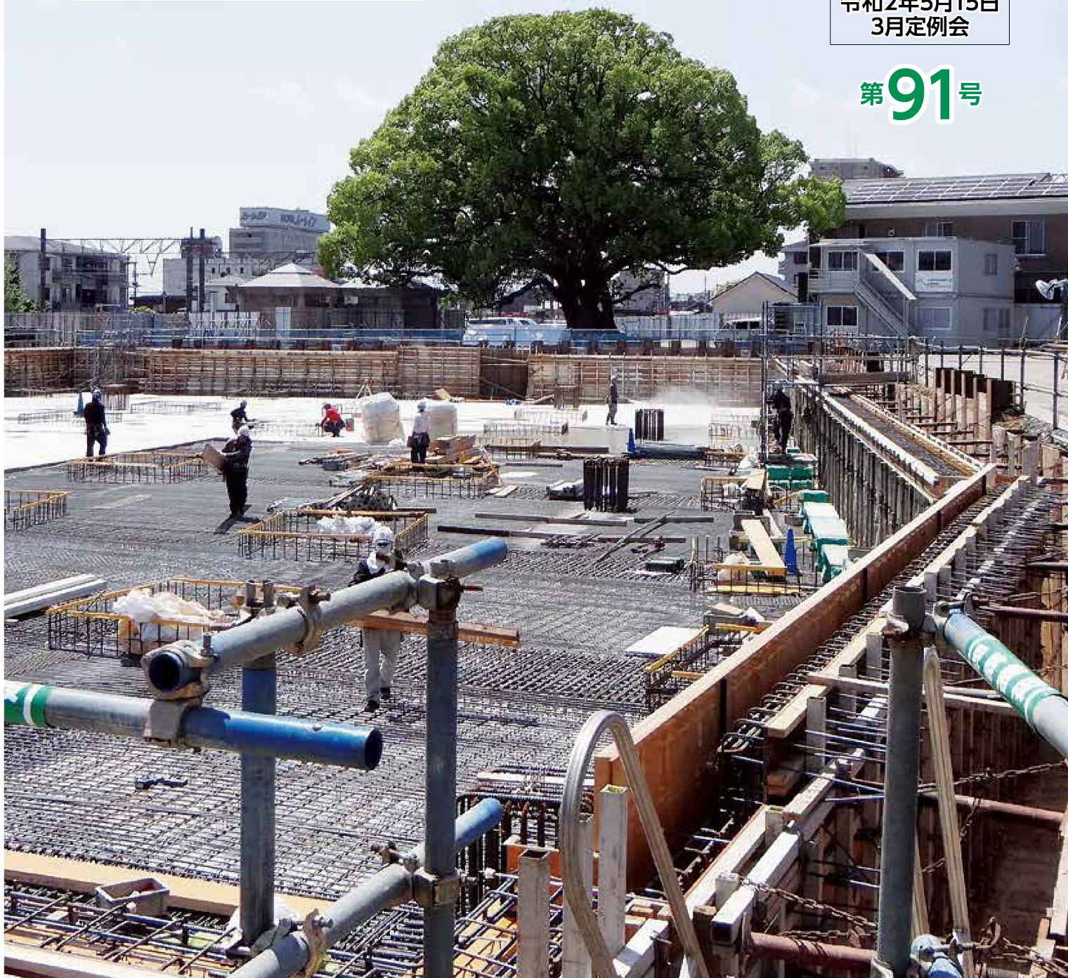
建設中の新庁舎
