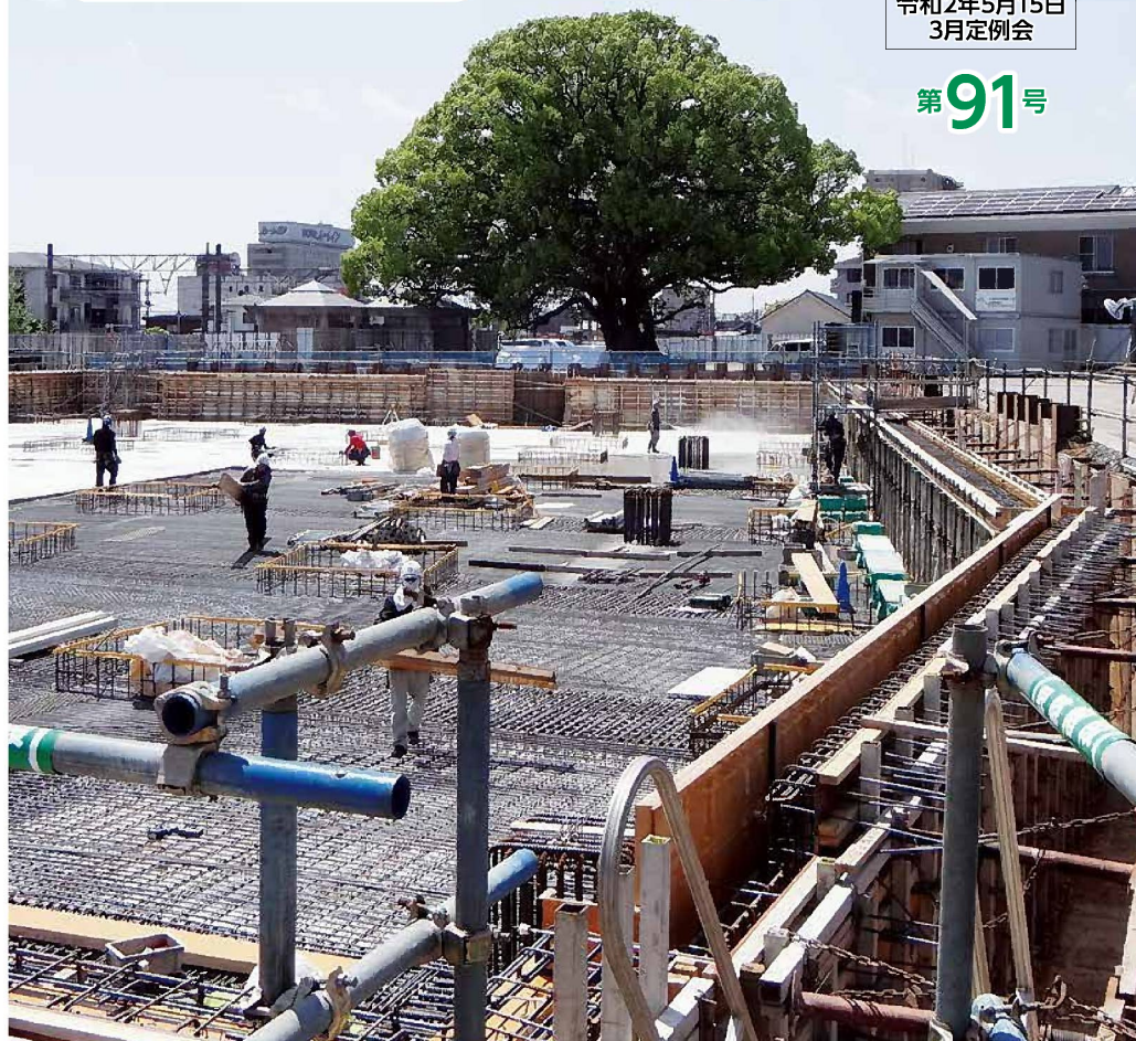
建設中の新庁舎
