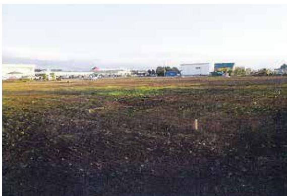
解体造成後の現地写真
