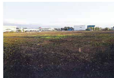
解体造成後の現地写真
