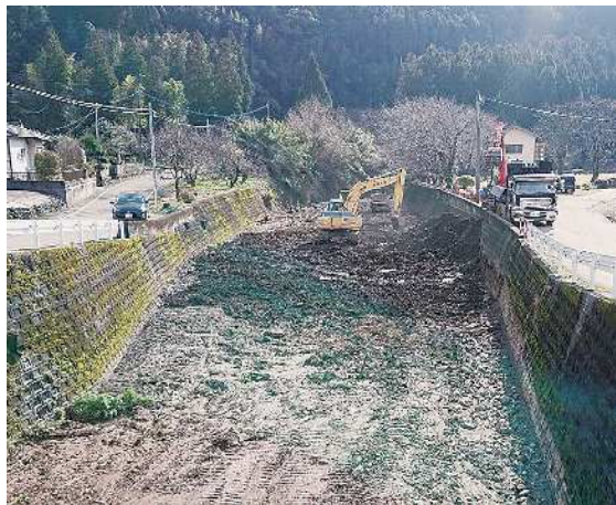
河川整備の様子
