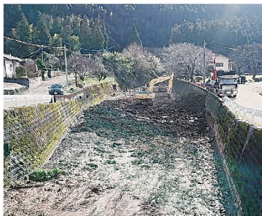
河川整備の様子
