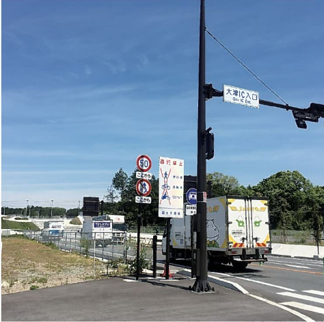
国道57号北側復旧ルート入口(大津IC)
